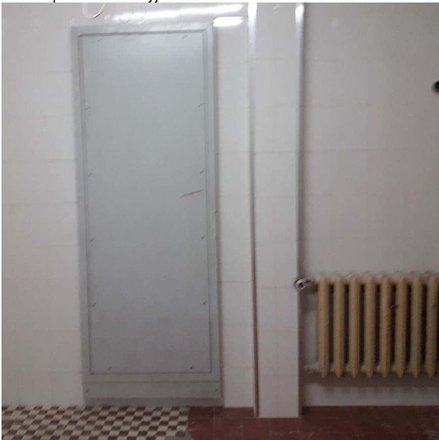
fot.04 - posadzka w korytarzu - zaprojektowano zmianę funkcji pomieszczenia na wc męskie i wyburzenie istniejącej ścianki działowej, podłoga tylko na fragmencie pomieszczenia, ubytki po wyburzonej ścianie, w sąsiednich pomieszczeniach istn.gres
