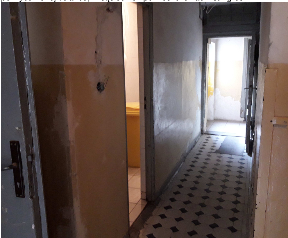
fot.04 - posadzka w korytarzu - zaprojektowano zmianę funkcji pomieszczenia na wc męskie i wyburzenie istniejącej ścianki działowej, podłoga tylko na fragmencie pomieszczenia, ubytki po wyburzonej ścianie, w sąsiednich pomieszczeniach istn.gres
