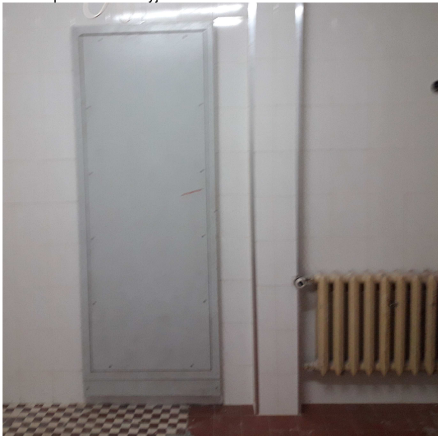
fot.03 - posadzka w myjni wózków
