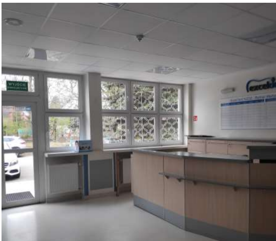
Zdjęcie nr13: Istniejące okna i stolarka drzwiowa z PVC- wejście główne od strony rejestracji.
